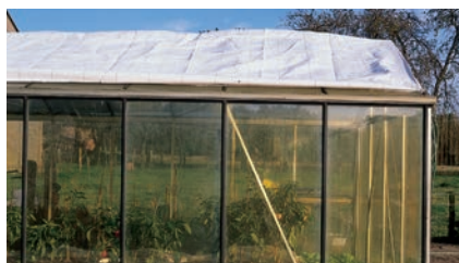
Een scherm aan de buitenkant houdt de zonnewarmte beter buiten, maar is gevoeliger voor slijtage.
